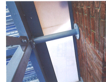
Koppelbuis is tevens kabel- en leidingdoorvoer.
